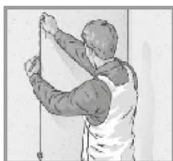
Per le installazioni in teli verticali battere il piombo. Per le installazioni in teli orizzontali aiutarsi con una bolla
